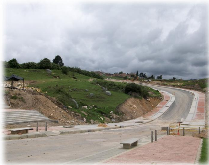
Foto 3. Construcción vía Usminia. Archivo personal.
