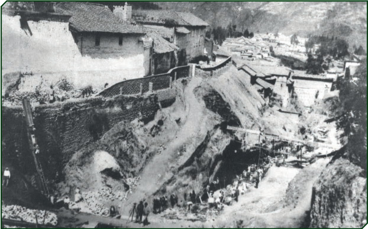
Figura 7. Canalización de la quebrada de Ullaguangayacu, c.1905 Fuente: Anónimo. Archivo Histórico, Ministerio de Cultura y Patrimonio, 80.F0000.1104
