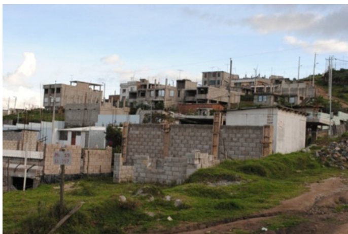
Foto 1. Viviendas de bloque en Rancho Alto José Peralta
