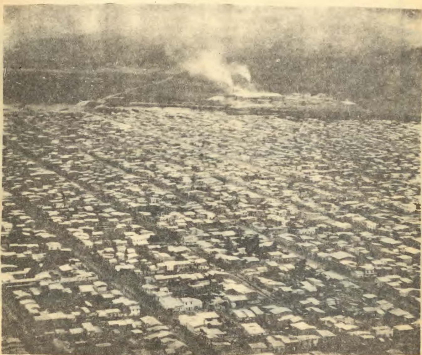
Foto n° 9. Parte del suburbio, al fondo la fábrica de cemento Rocafuerte
