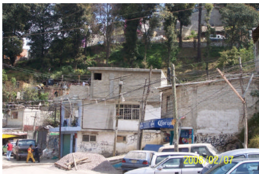
Foto 8. Tierra Colorada. Se observa como los habitantes resolvieron su necesidad de electricidad, con conexiones de contrabando. Cortés, 2008.
